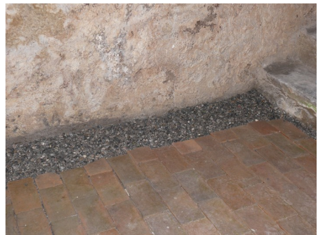
Trockenlegung der Sockelzone
