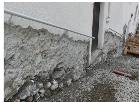
Erneuerung des Fassadenputzes
